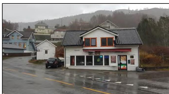
Figur 5-14: Ervikveien 19, nr. 3 på Figur 5-12. Bygningen har vært gjennom flere ombygginger, senest som restaurant. Foto Byantikvaren 2018
