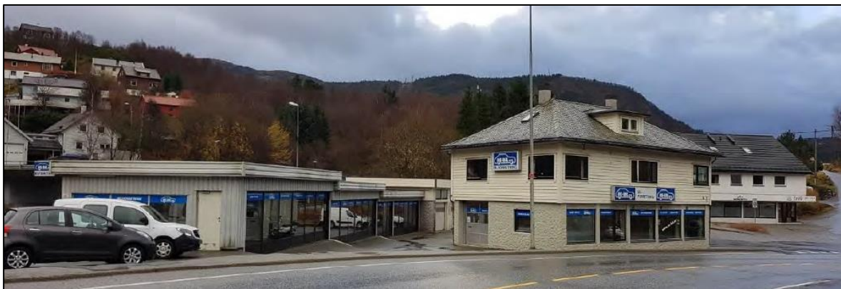
Figur 5-17: Nr. 2 på figur 5-15. Næringslokaler på bakkeplan med bolig i overetasjen. Foto Byantikvaren 2018.
