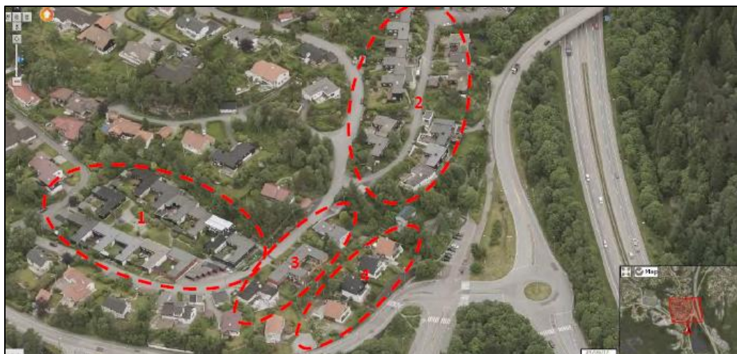
Figur 5-19: Skråfoto som viser 1-3: L-formet atriumhus fra 1960-årene, 4: Kjedehus fra 1963. Skråfoto sett mot nord. Illustrasjon, Byantikvaren 2018.
