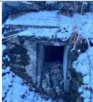
Figur 7-19: Bunker som skal rives. Foto: Norconsult
