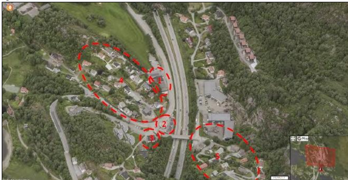
Figur 5-15: Skråfoto som viser 1: Tidligere garasje til Åsane billag, 2: Næring med bolig, 3: Næring med bolig, 4: Boligbebyggelse fra 1930-1970, 5: Boligbebyggelse hovedsakelig fra 1950-årene og 1960-årene. Skråfoto sett mot nord. Illustrasjon, Byantikvaren 2018.
